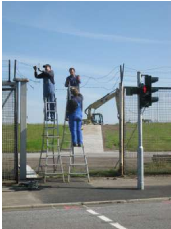
21 Bauarbeiten für die Öffnung des Zollzauns (Foto Rothschuh)
